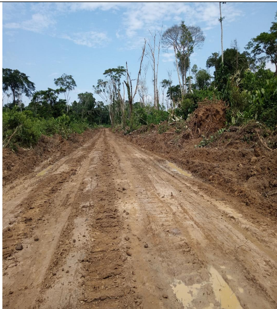
Fig. 13 : La route principale en cours d'ouverture, AAC2.2-OUEST
